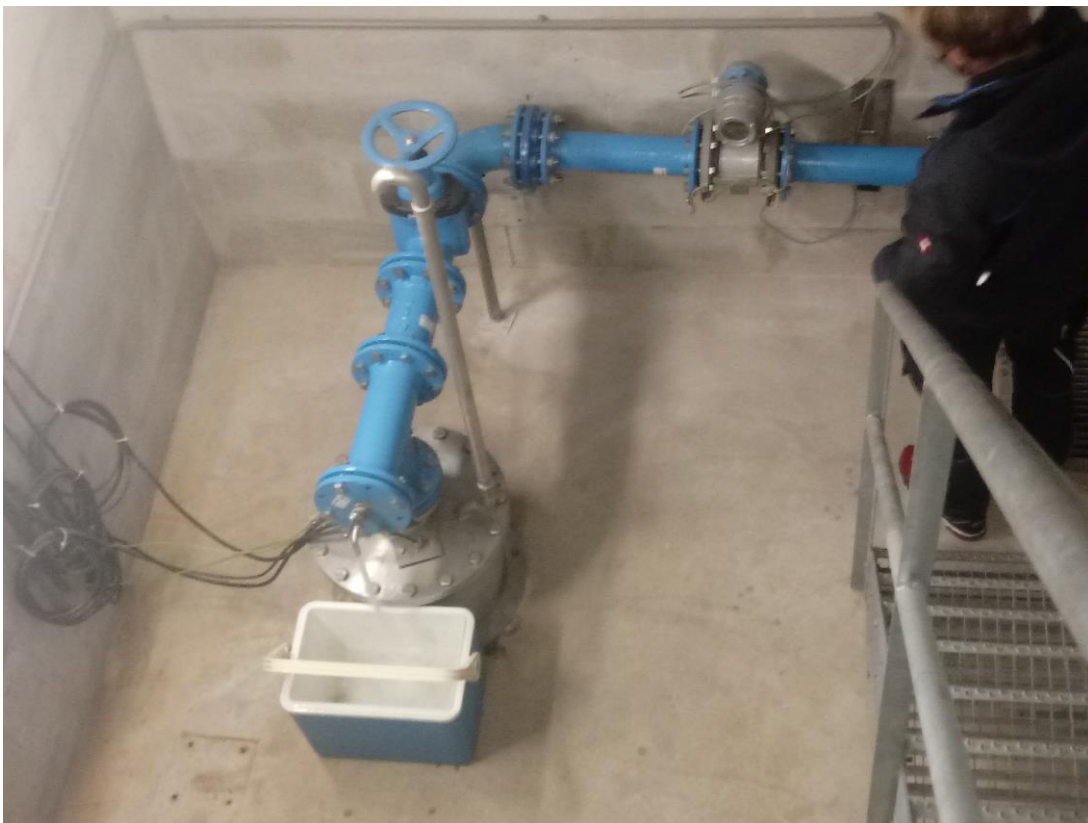
Abbildung 8: WVA Gemeindewasserversorgungsverband Felixdorf – Sollenau, Bohrbrunnen 2, Blick zum Brunnen.
