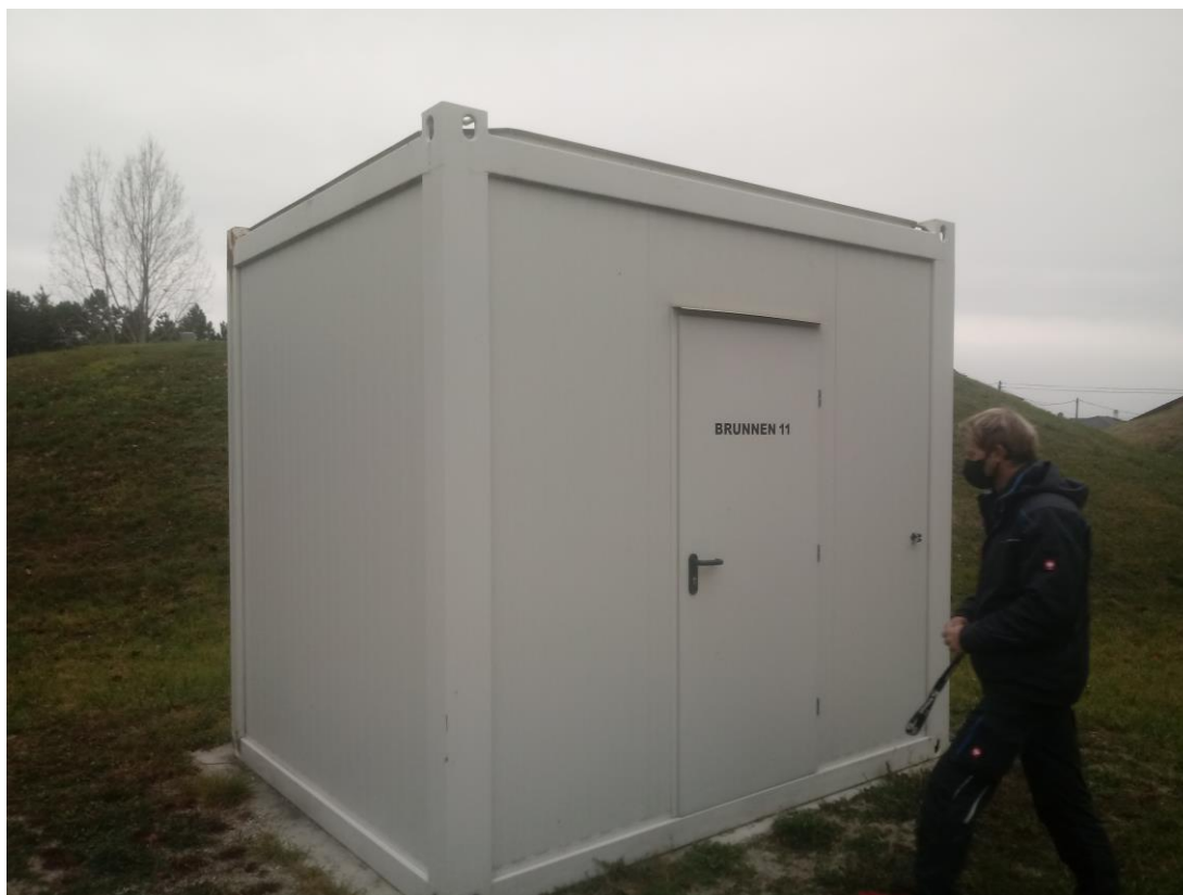
Abbildung 10: WVA Gemeindewasserversorgungsverband Felixdorf – Sollenau, Bohrbrunnen 11, Blick zum Brunnenhaus.
