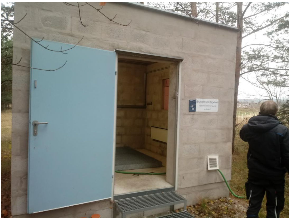
Abbildung 4: WVA Gemeindewasserversorgungsverband Felixdorf – Sollenau, Bohrbrunnen 6, Blick zum Brunnenhaus.
