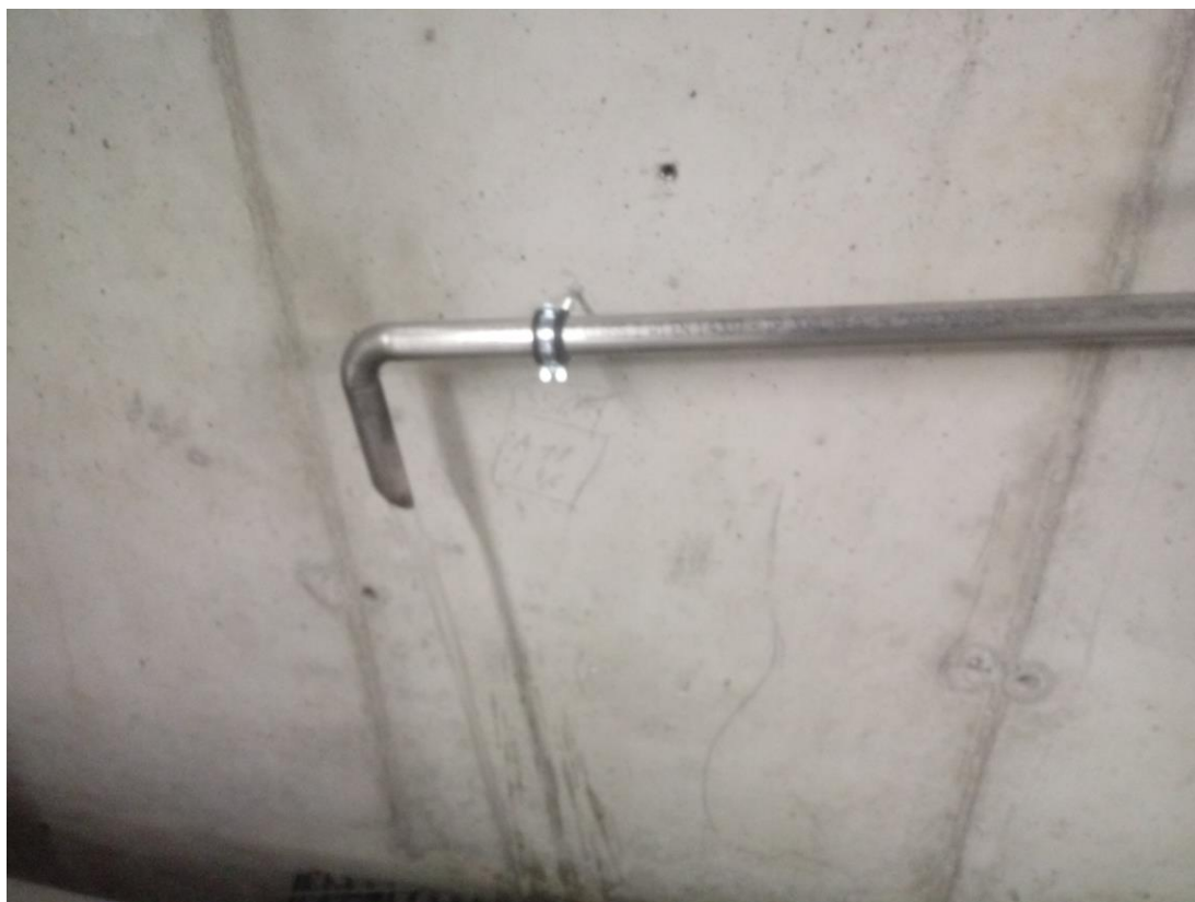
Abbildung 28: WVA Gemeindewasserversorgungsverband Felixdorf – Sollenau, Tiefbehälter 2 Felixdorf, Probenahmeahn Ablauf.
