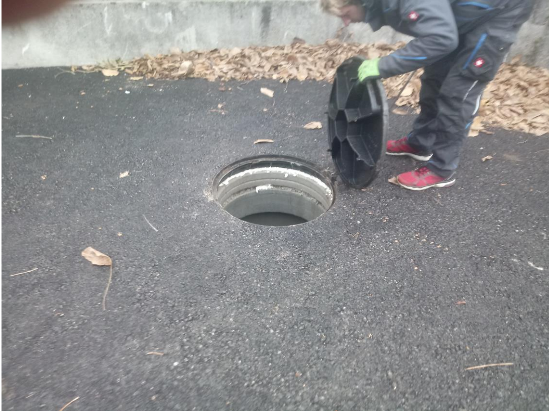
Abbildung 35: WVA Gemeindewasserversorgungsverband Felixdorf – Sollenau, Ortsnetz Felixdorf, Bereich Süd, Blick zum Schacht bei Stampfgasse Nr. 9.
