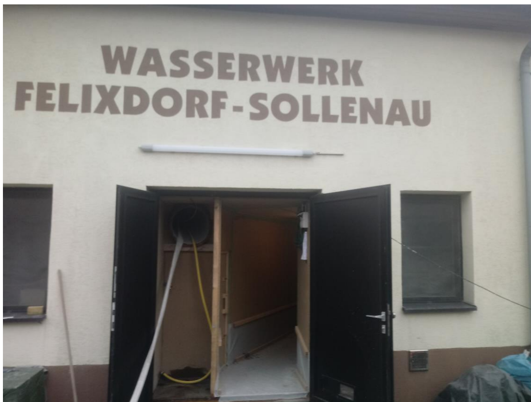
Abbildung 29: WVA Gemeindewasserversorgungsverband Felixdorf – Sollenau, Blick zum Tiefbehälter 3 Sollenau.
