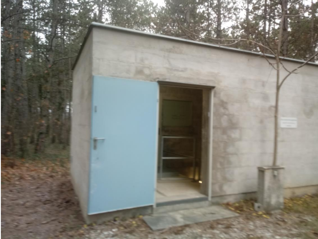
Abbildung 7: WVA Gemeindewasserversorgungsverband Felixdorf – Sollenau, Bohrbrunnen 2, Blick zum Brunnenhaus.
