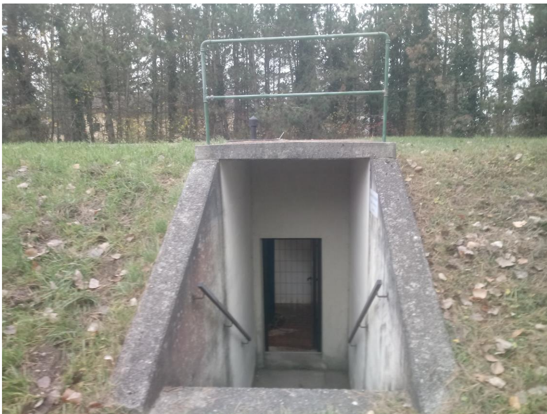
Abbildung 31: WVA Gemeindewasserversorgungsverband Felixdorf – Sollenau, Zugangsbereich zum Bohrbrunnen 8a Sollenau.
