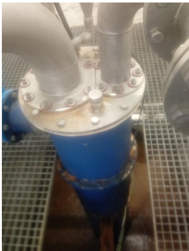
Abbildung 14: WVA Gemeindefwasserversorgungsverband Felixdorf – Sollenau, Bohrbrunnen 7, Blick zum Brunnen.
