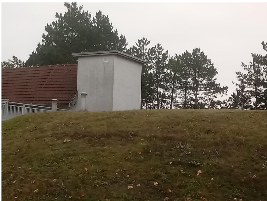
Abbildung 26: WVA Gemeindevasserversorgungsverband Felixdorf – Sollenau, Blick zu Belüftungspilzen des Tiefbehälter 2 Felixdorf.
