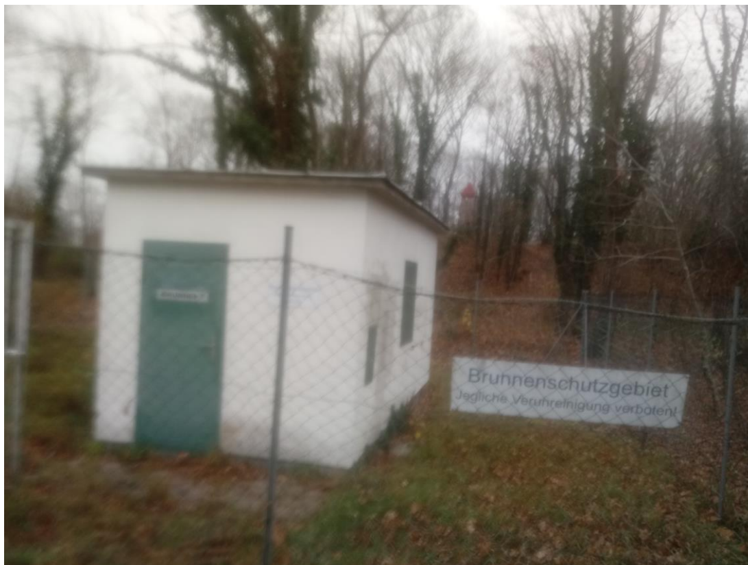
Abbildung 13: WVA Gemeindefwasserversorgungsverband Felixdorf – Sollenau, Bohrbrunnen 7, Blick zum Brunnenhaus.
